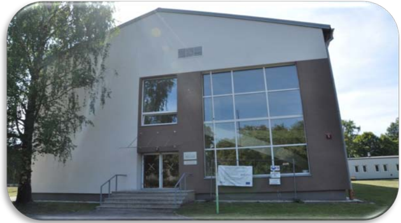
Rekonstrukcija LLU laboratoriju kompleksā Strazdu ielā – investēts aprīkojuma uzlabošanā, lai kompleksu kā mācību un pētījumu bāzi var izmantot LLU studenti un zinātnieki.
